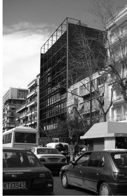
ΕΙΚ. 10. ΑΛΕΞΑΝΔΡΟΣ ΤΟΜΠΑΖΗΣ. ΚΤΙΡΙΟ ΓΡΑΦΕΙΩΝ ΣΤΗ ΛΕΩΦΟΡΟ ΑΛΕΞΑΝΔΡΑΣ, 1991-95.
