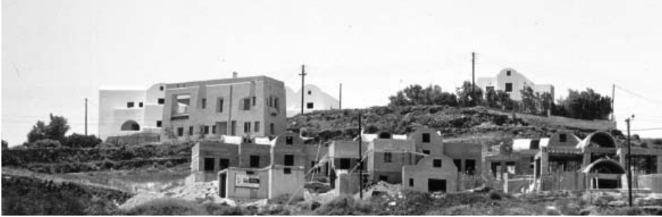
ΕΙΚ. 15. ΚΤΙΣΜΑΤΑ ΕΠΙ ΛΟΦΟΥ ΣΤΟ ΑΚΡΩΤΗΡΙ ΣΑΝΤΟΡΙΝΗΣ
